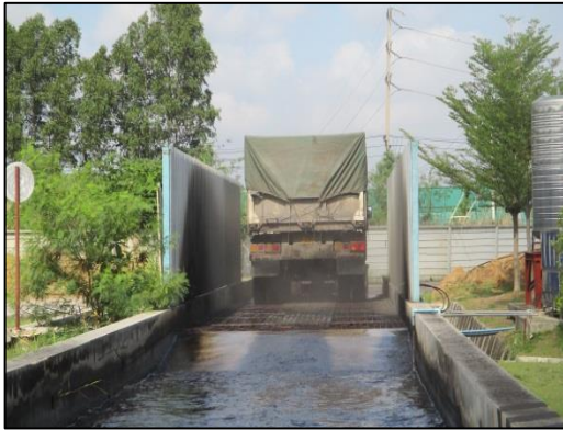
ภาพที่ 2.4 บ่อล้างล้อรถบรรทุกก่อนออกจากพื้นที่ก่อสร้าง
