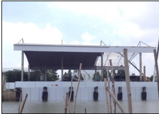
ภาพที่ 2.17 ม่านดักตะกอนป้องกันเศษดินหรือตะกอนดินตกลงสู่น้ำป่าสัก
