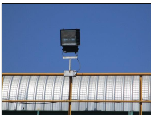
ภาพที่ 2.23 ติดตั้งระบบไฟฟ้าแสงสว่างบนท่าเทียบเรือ
