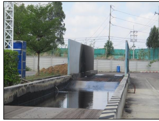
ภาพที่ 2.4 บ่อล้างล้อรถบรรทุกก่อนออกจากพื้นที่ก่อสร้าง
