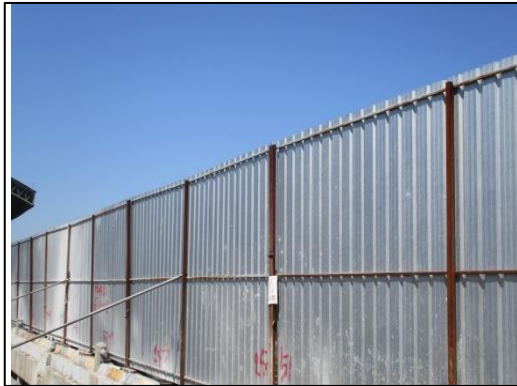
ภาพที่ 2.1 รั้วแผ่นเหล็ก (Metal sheet)
